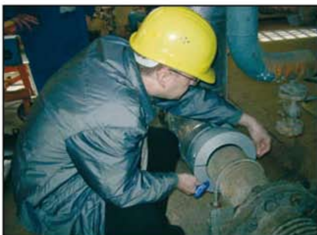
τοποθέτηση ενός δακτυλιδιού 8" σε βιομηχανική εγκατάσταση
