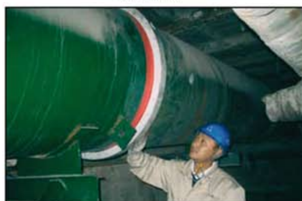
40" δακτύλιος σε τροφοδοσία νερού στην Κίνα σε βιομηχανία χάλυβα
