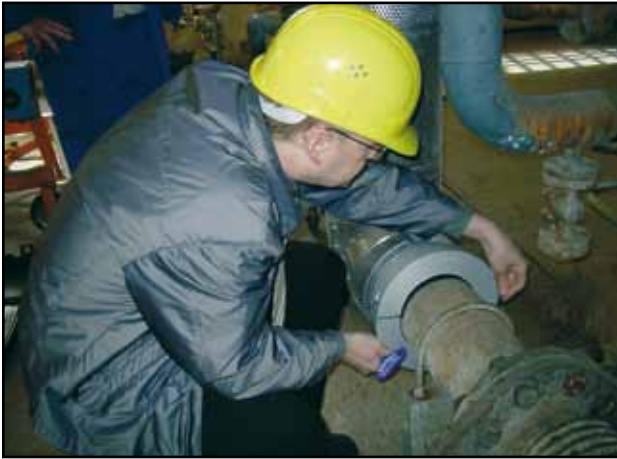
Montage eines 8" Rings an einer Industrieanlage
