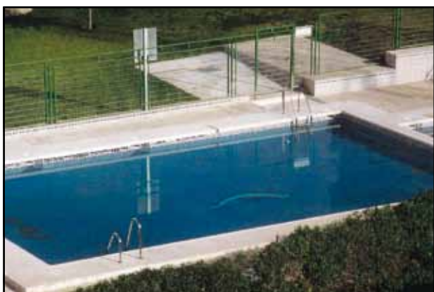
Schwimmbad mit WELLAN® 2000
